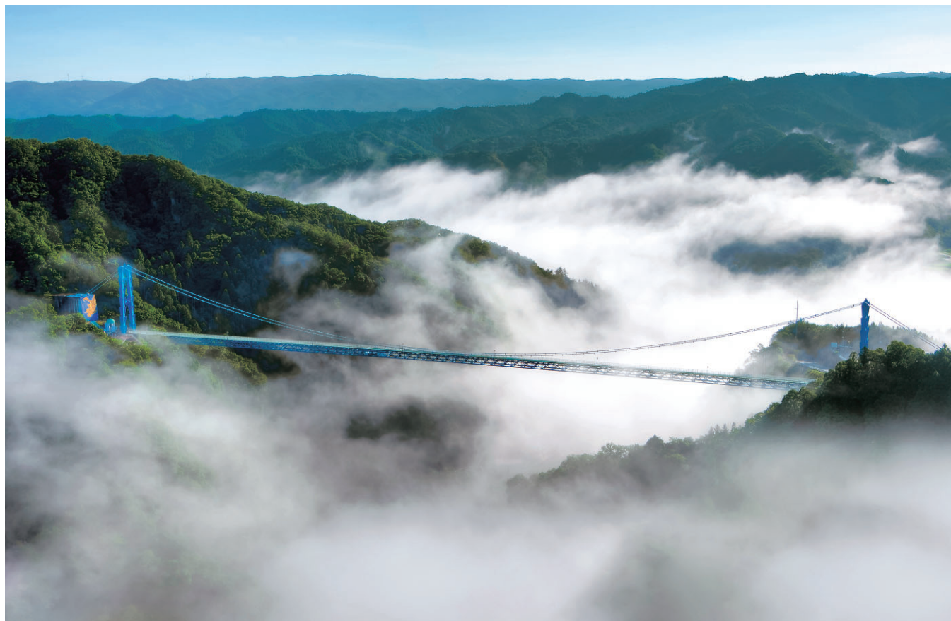
竜神大吊橋（常陸太田市天下野町）
